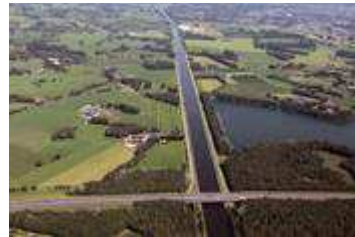
Zijtak Twentekanaal tussen de A1 en de A35
